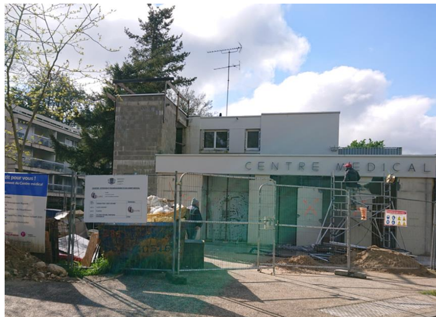
Photos du chantier en date du 1 er mai 2024
